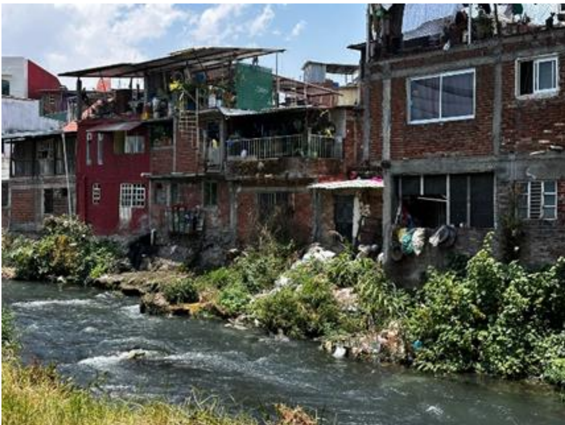
Imagen 3.2 Fotografía donde se puede apreciar las invasiones a la zona federal del río.
