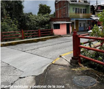
Puente vehicular y peatonal de la zona
