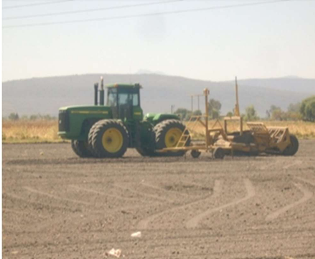
Maquinaria con niveladora y rayo láser
