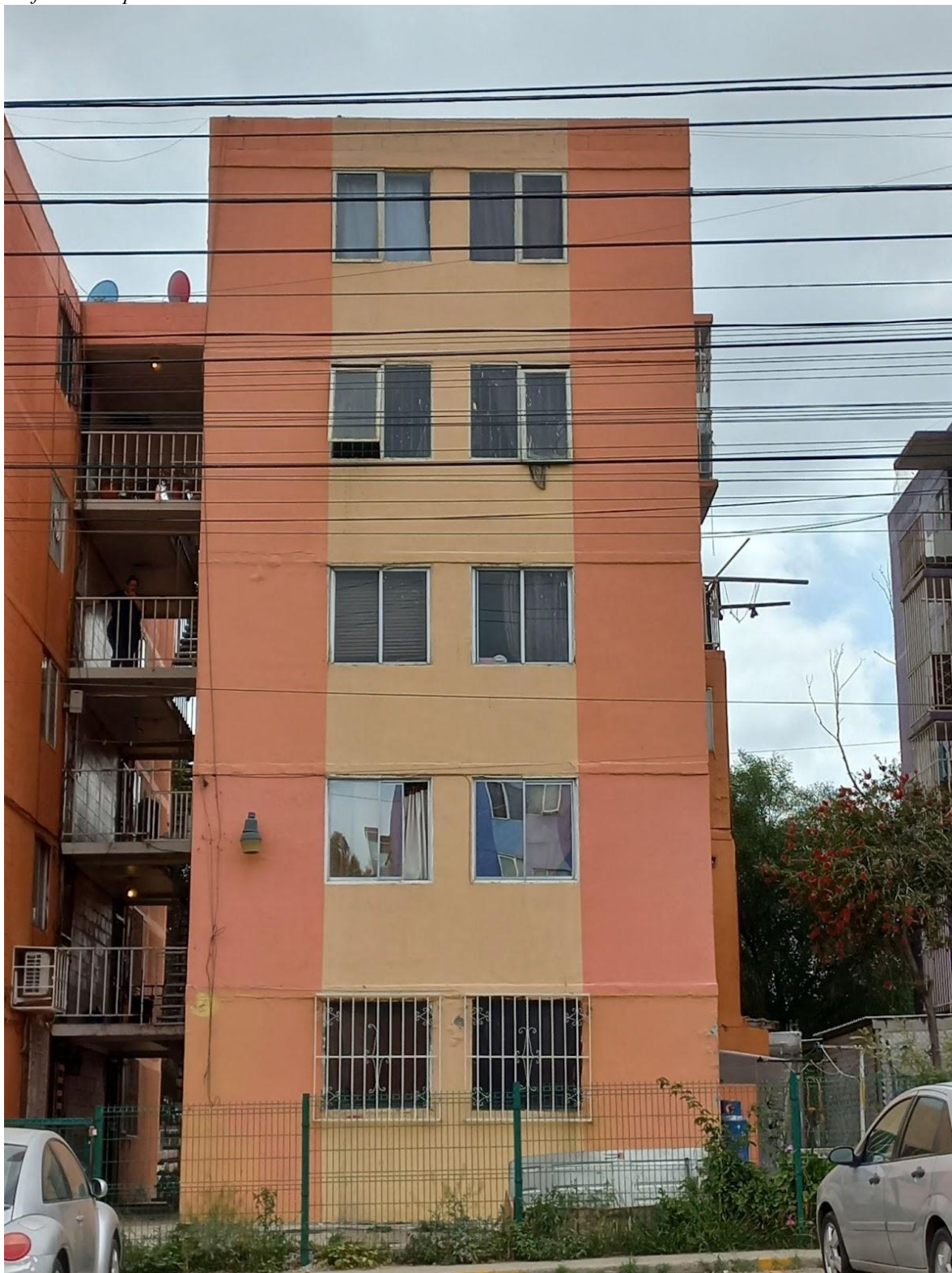
Edificio de departamentos
