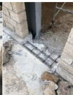
Imagen 19. Demolición de zoclo.
