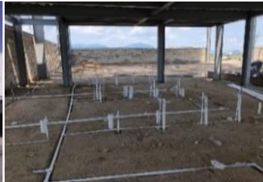
Imagen 6. Demolición de instalaciones.
