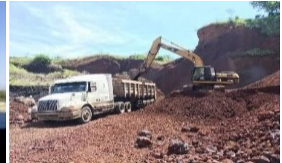
Imagen 5. Relleno de terreno para elevación de nave.
