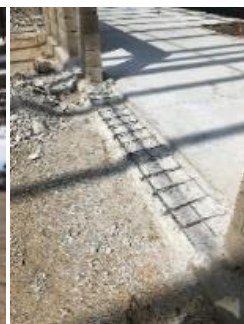
Imagen 19. Demolición de zoclo.
