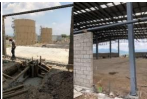
Imagen 21. Demolición de muro por adecuación de columnas
