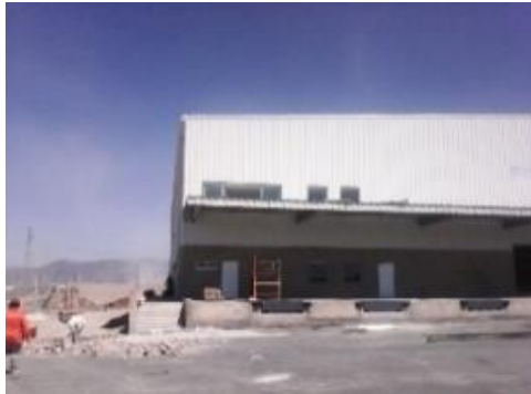
Imagen 7. Construcción de escalera peatonal.
