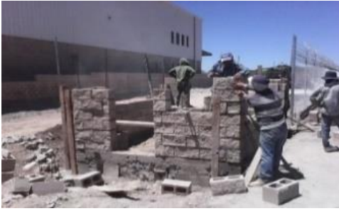
Imagen 2. Construcción de caseta de ingreso.
