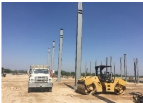
Imagen 15..Adecuación de elementos ya existentes por cambio de estructura.
