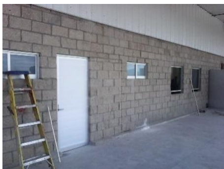
Imagen 10. Cierre de hueco de puerta con material.
