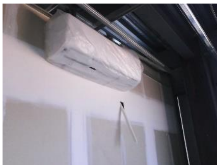
Imagen 20. Adición de equipo de aire acondicionado.
