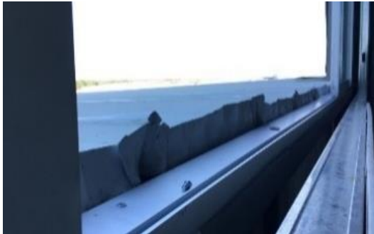
Imagen 4. Modificación de altura de ventanas.
