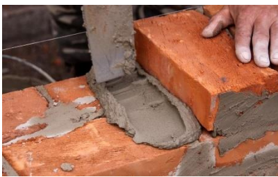
Cemento (muros y losas)
