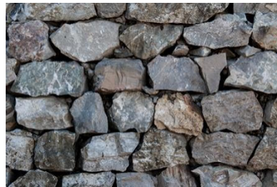
Piedra Braza (cimentación)
