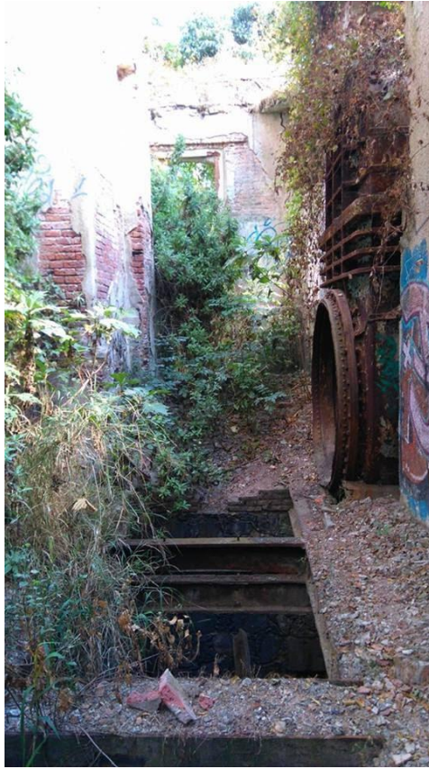
Figura XXIV. Interior actual Hidroeléctrica y Textiles
