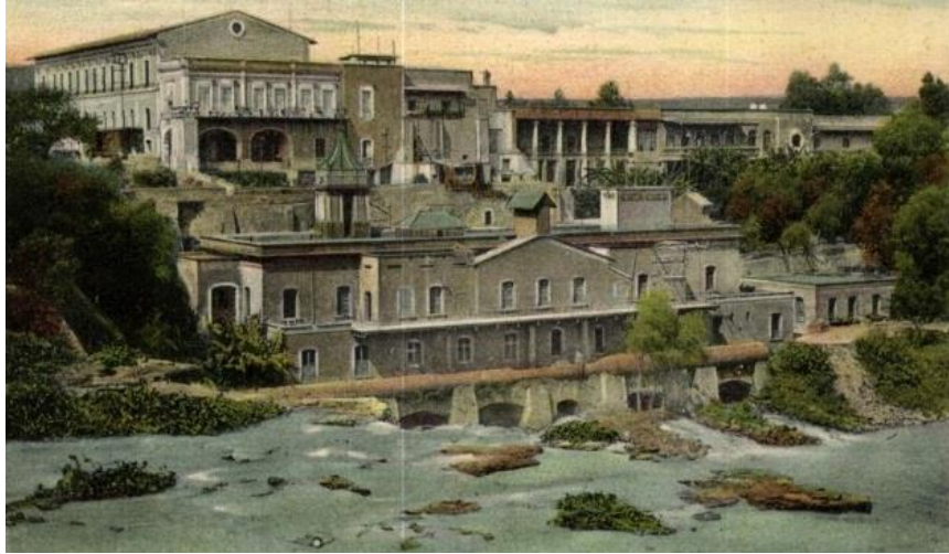
Figura XIX. Fábrica de hilados e hidroeléctrica
