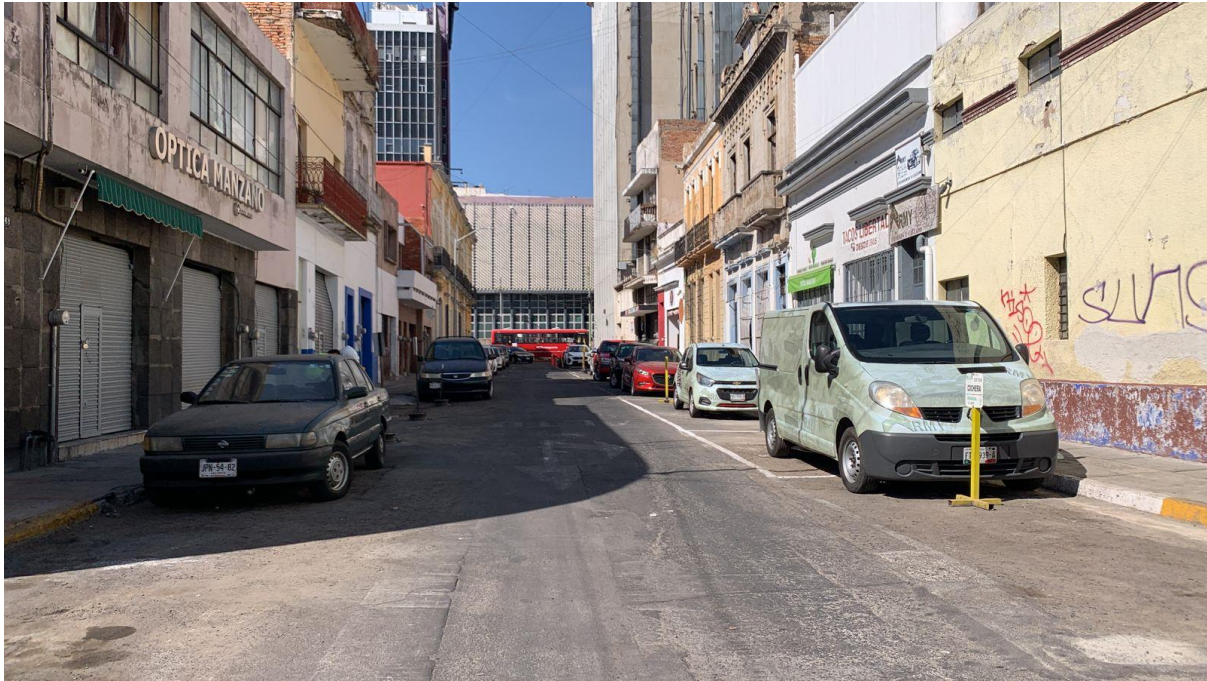
Figura 64. Fotografía del estado actual de la calle Manzano.
