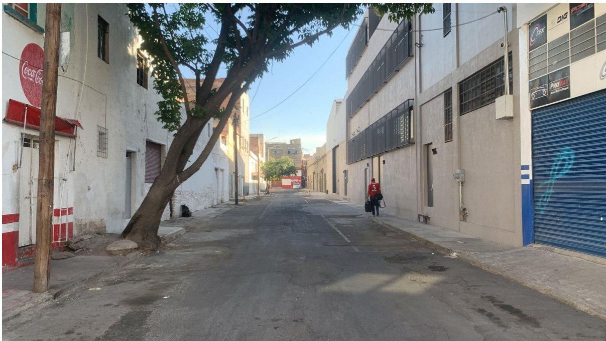
Figura 64. Fotografía del estado actual de la calle San Fernando.
