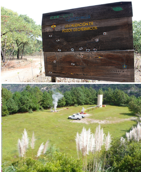
Ilustración 6 / Instalaciones de la planta de energía geotérmica en La Primavera. Arriba, mapa de localización de los pozos perforados. Imágenes tomadas de Magis ITESO.
