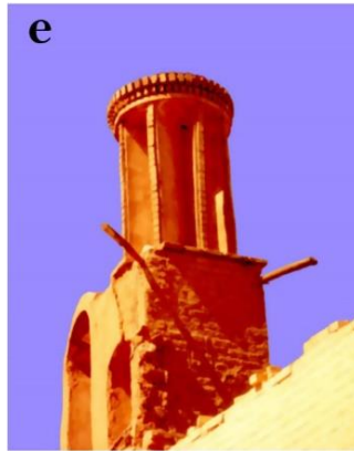
Imagen 11. Torre de viento de forma cilíndrica en Yazd, Irán. Fuente: (Bahadori & Dehghani-sanji, 2014).
