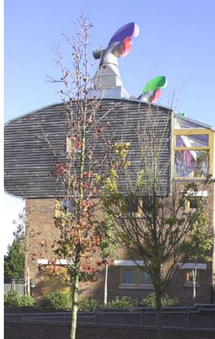
Imagen 15. Ventilación BedZed, Londres. Fuente: (Lyon, 2009).
