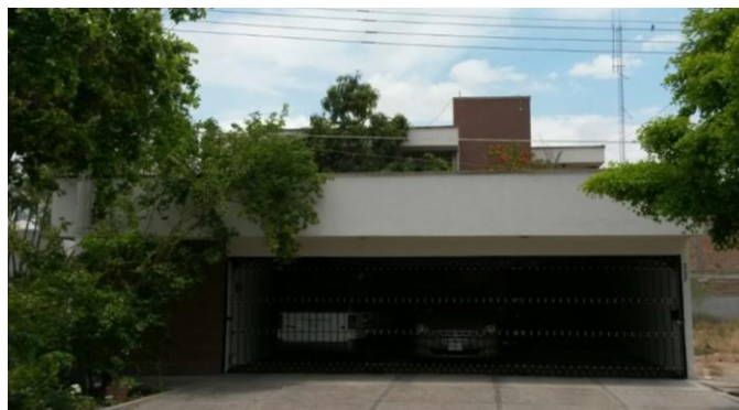
Imagen 28. Fachada de la vivienda para el caso de estudio. Fuente: Elaboración propia.
