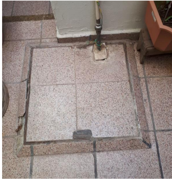
Imagen 36. Tapadera de cisterna.
