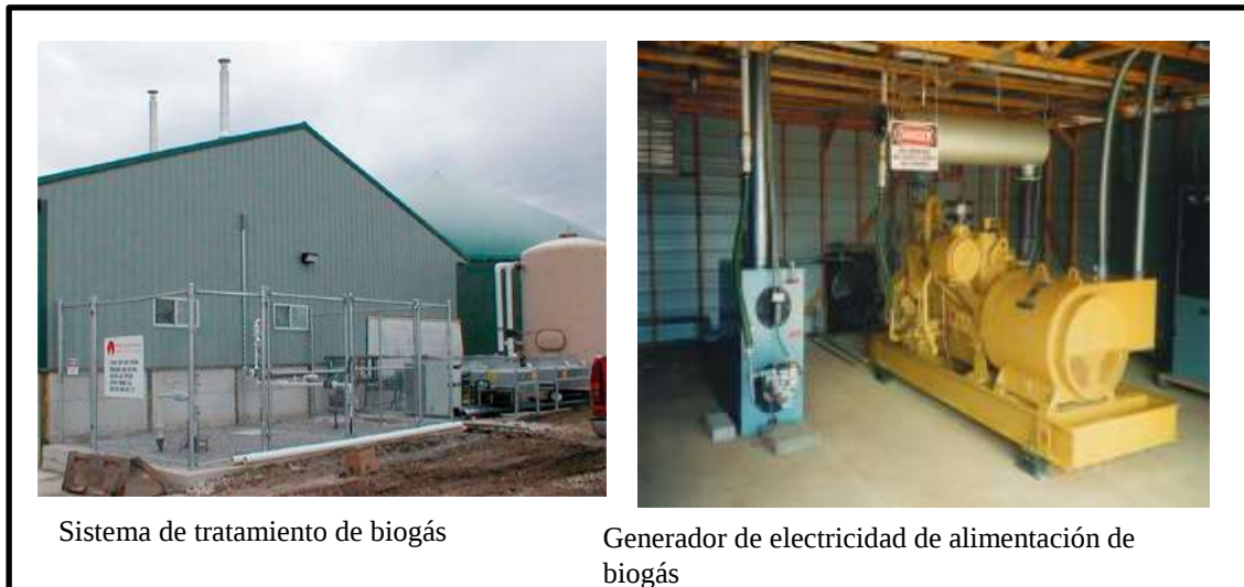
Cuadro 5 Sistema de tratamiento de biogás y generador de electricidad
