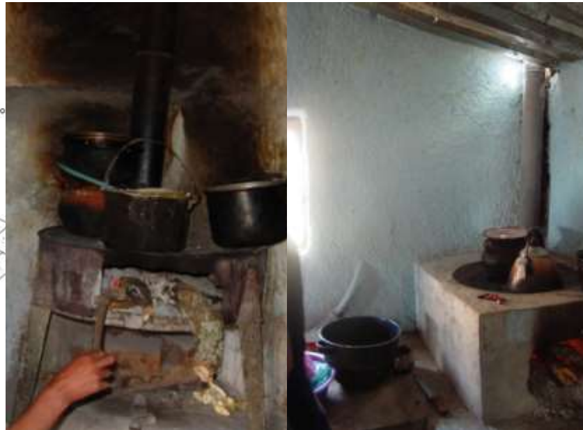
Antes y después de la instalación del fogón sin humo vivienda F11-MSV
