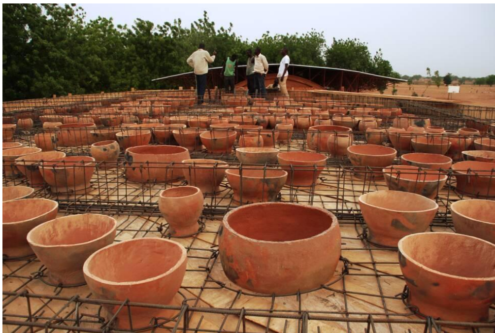
Figura 11: Fotografía por Keré Architecture, Trabajadores de la construcción instalando ollas de barro en el techo de la biblioteca de la escuela de Gando , Ciudad de Gando, Burkina Faso, 2010-2018, 980x653ppp. Consulta 18/IV/2023. https://www.kerearchitecture.com/work/building/gando-primary-school-library
