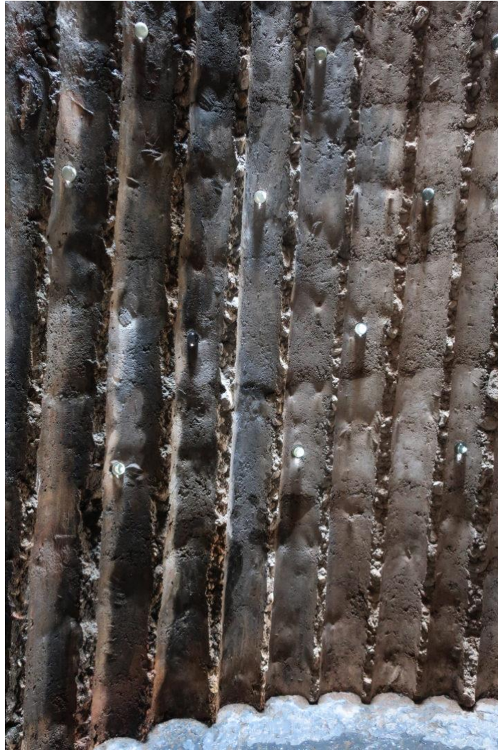
Figura 17: Textura de las paredes, orificios de la cimbra e imagen del piso de plomo. Guillermo, Bruder Klaus Chapel , 01/06/2017, 720x1080 ppx, https://es.wikiarquitectura.com/bruder_klaus_13/ . Consultado 07/01/2023.
