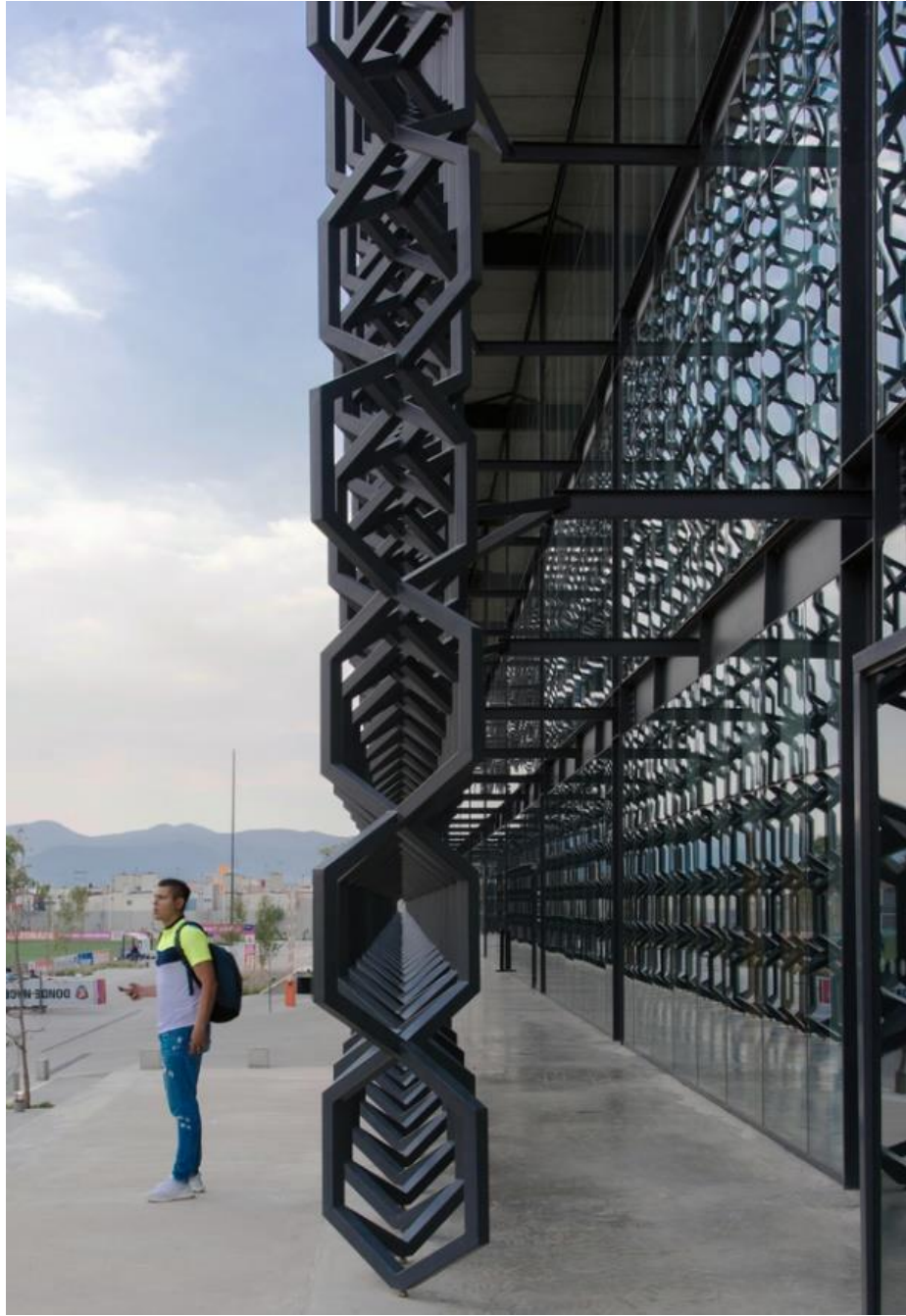
Figura 2: Detalle de la piel exterior sobre la fachada principal. Arroyo Solís Agraz Arquitectos, FEMEXFUT Edificio Sede de la Federación Mexicana de Fútbol , 2017, Toluca, México, Fotografías por Jaime Navarro.
