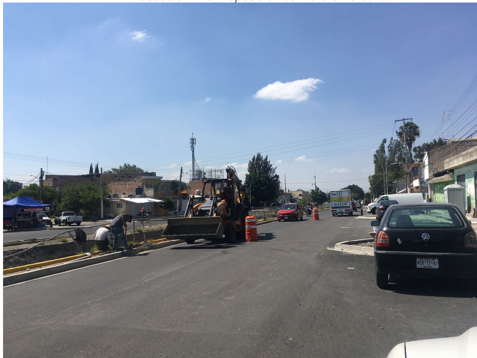
Ilustración 128. Reposición de malla en el canal.
