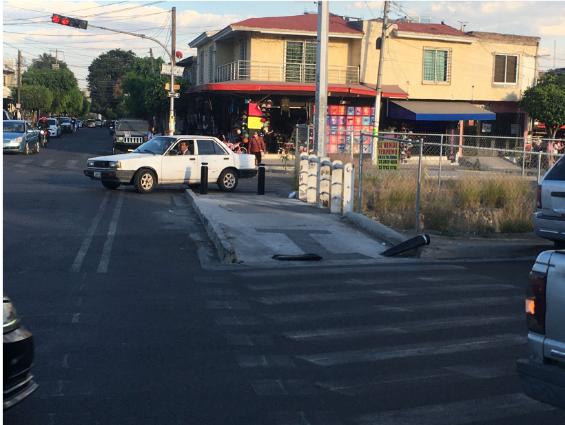
Ilustración 112. Nuevos bolardos completamente dañados.
