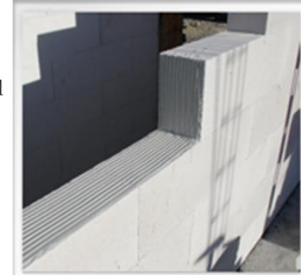
Muro de block Hebel
