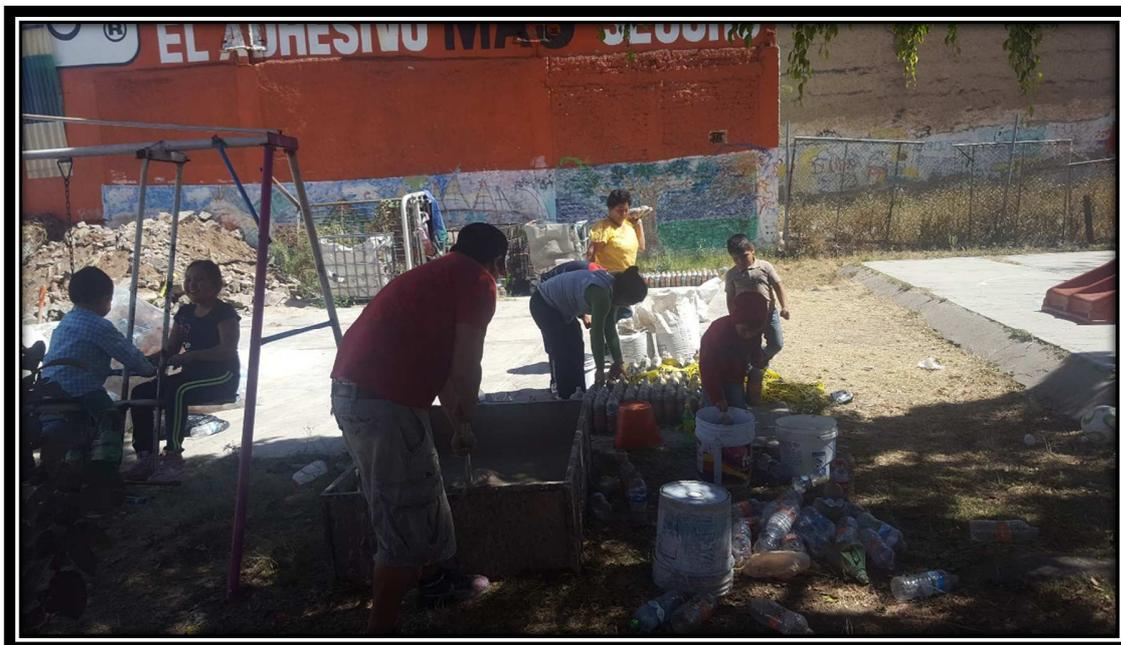
Fotografía 23, Mezclado de arena y cal, para preparación de Mezcla para relleno de botellas.
