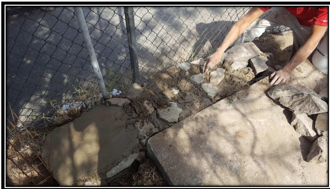
Fotografía 29, cimentación de muro de PET. Imagen propia.
