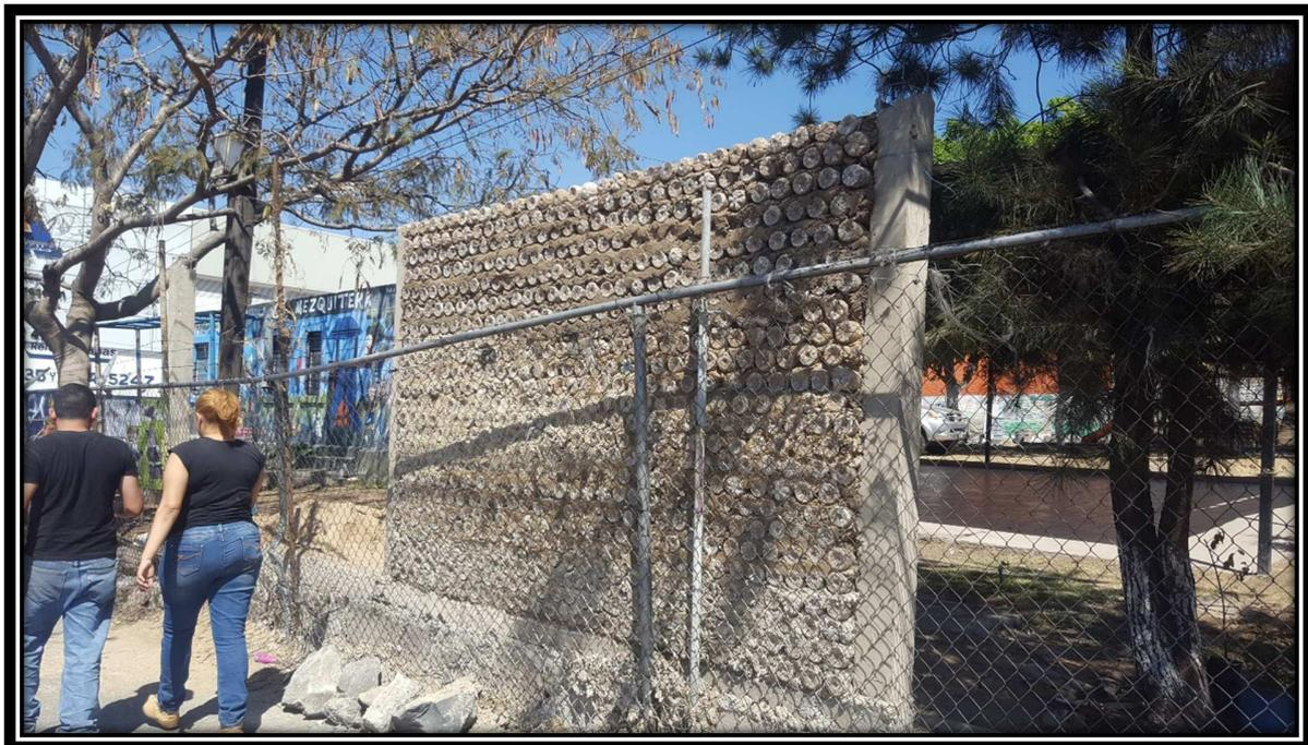
Fotografía 38. Primer módulo del proyecto de barda perimetral con PET en la Mezquitera. Fuente propia.
