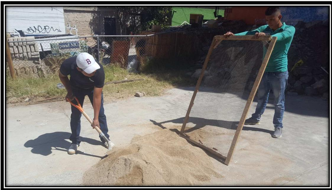
Fotografía 21, Cribado de arena para preparación de Mezcla para relleno de botellas.
