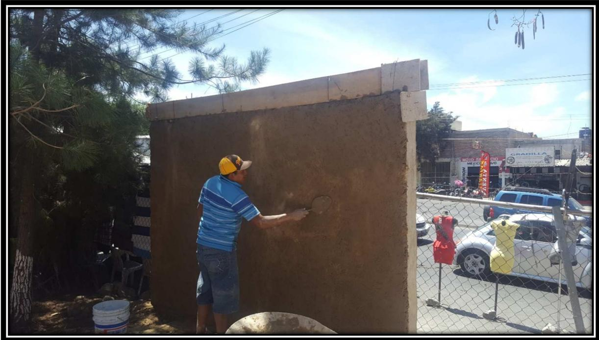
Fotografía 33, Terminado Aplanado de muro de PET. Imagen propia.
