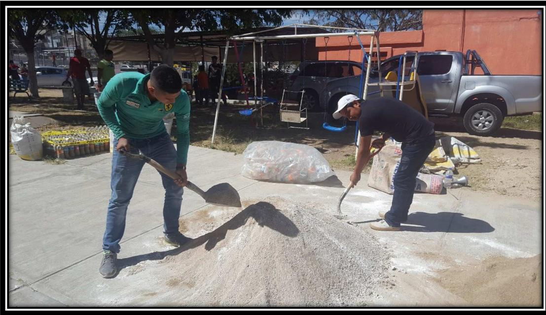
Fotografía 21, Mezclado de arena y cal, para preparación de Mezcla para relleno de botellas.
