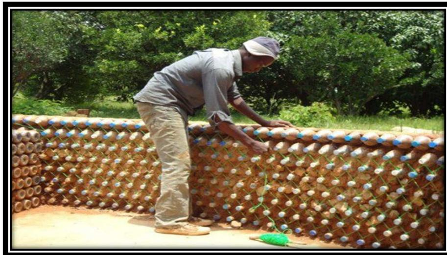
Imagen 19. Otro ejemplo de muro de botellas de PET rellenas con material del lugar y asentada con una mezcla de material del lugar. Fuente: <http://www.diarioandino.com.ar>
