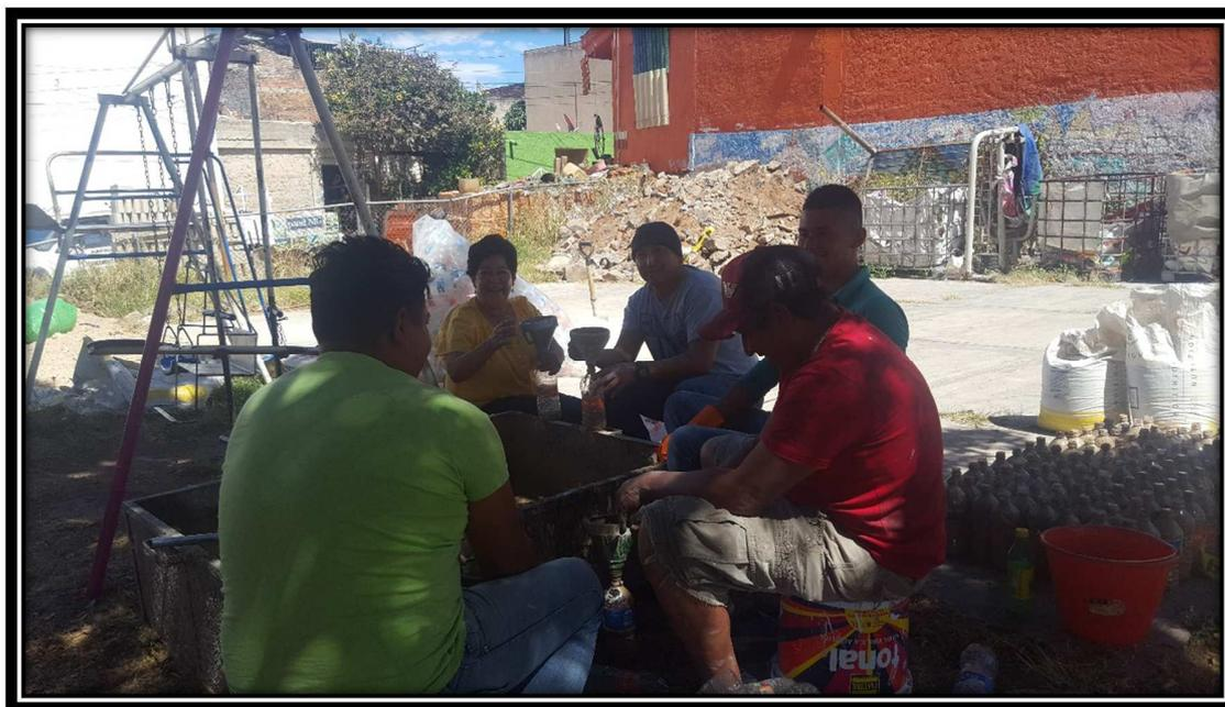
Fotografía 24, Mezclado de arena y cal, para preparación de Mezcla para relleno de botellas.
