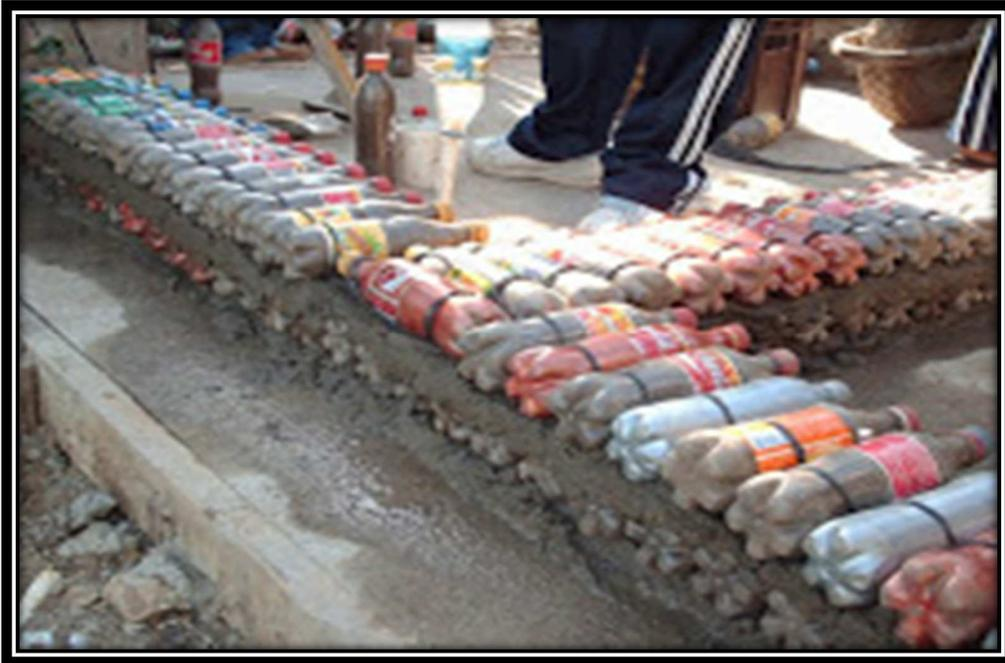
Imagen 15 Construcción con botellas de PET en Latinoamérica. Fuente: construcción con botellas.blogspot.mx
