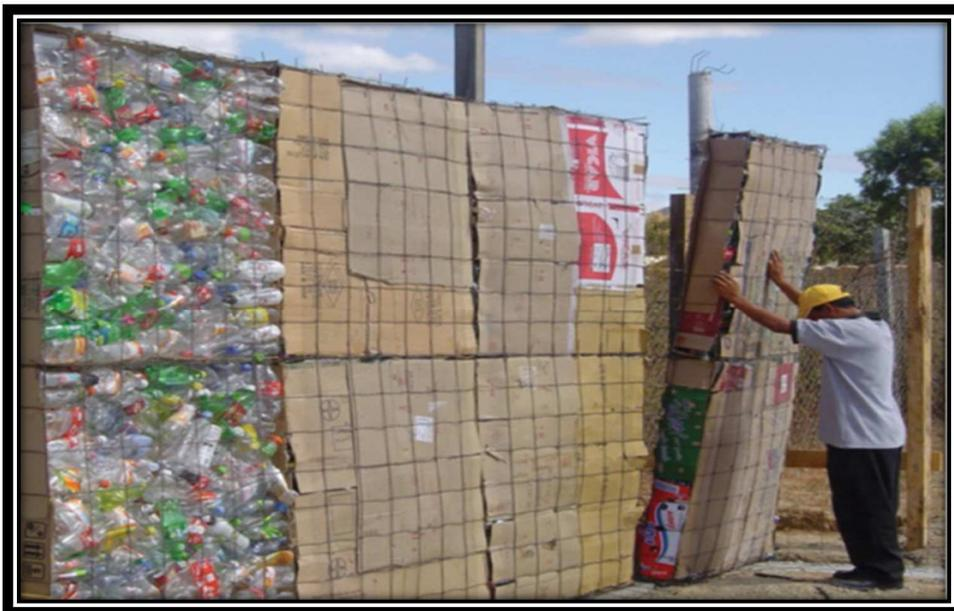
Imagen 16. Panel de botellas de PET recubiertas con cartón para posteriormente aplicar recubrimiento, Fuente: Caballero Montes y Alcántara Lomelí (2012)
