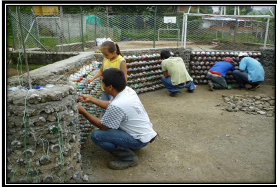
Imagen 18. Muro de botellas de PET rellenas con material del lugar y asentada con mortero cemento-arena
