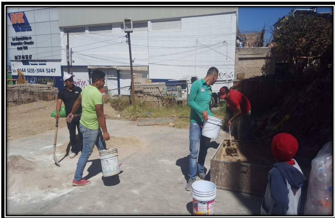
Fotografía 22, Mezclado de arena y cal, para preparación de Mezcla para relleno de botellas.
