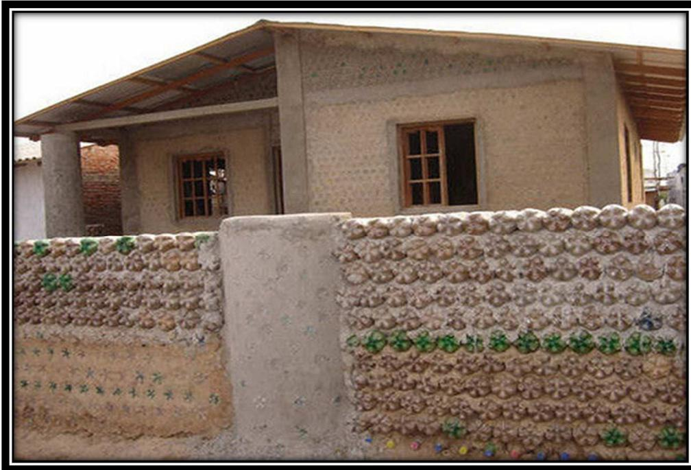
Imagen 17. Construcción de casas con sistema de PET en Tlaxcala México. Fuente: excelsior.com 2014
