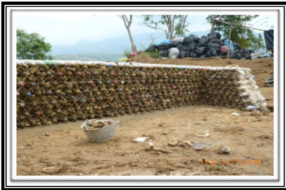
Imagen 14 Construcción con botellas de PET en Latinoamérica. Fuente: construcción con botellas.blogspot.mx
