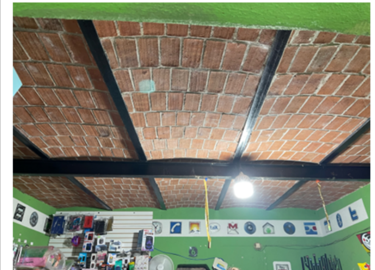
Interior del comercio, se observa bóveda catalana y viguería como tipo de losa.
