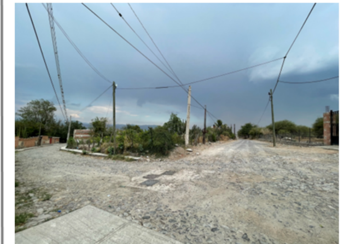
Cruce de cables eléctricos sin orden.
