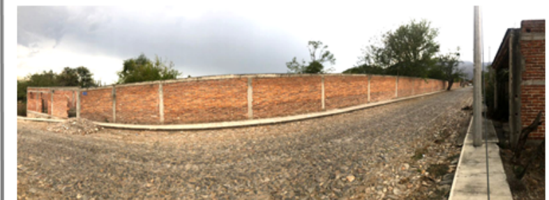
Banqueta continua del mismo predio.
