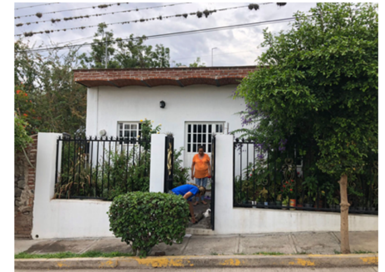
Fachada principal, Jardineras al frente de la casa.
