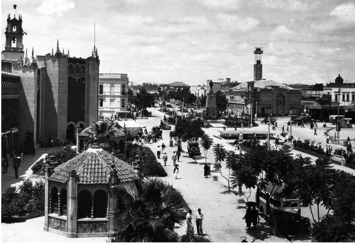
FIGURA 1.2 CIUDAD DE GUADALAJARA, AVENIDA INDEPENDENCIA, POSTERIOR AL ENTUBAMIENTO DEL RÍO SAN JUAN DE DIOS, IMAGEN A PRINCIPIOS DEL SIGLO XX
