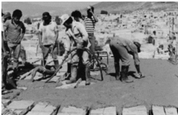
FIGURA 8.8 FABRICACIÓN DE LA LOSA ALIGERADA DE CONCRETO ARMADO
