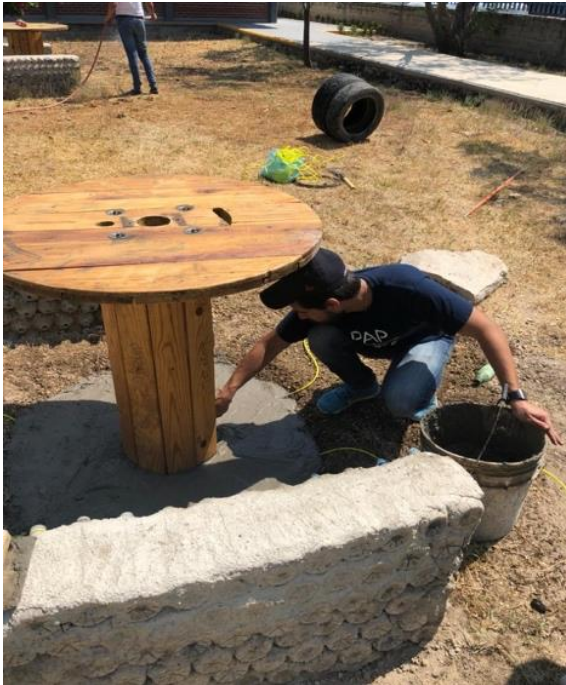
Ilustración 2. Empotramiento de carretes y unión de bancos con llantas a la mesa.
