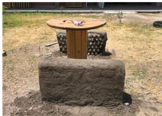
Ilustración 3. Enjarre de las bancas ya terminadas.
