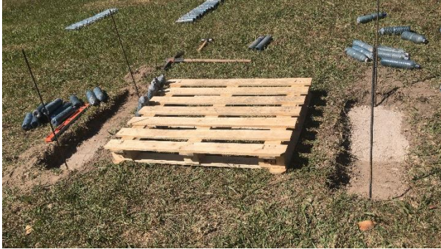
Imagen. 4. Trazo, limpieza y nivelación del área de construcción de bancas hechas con PET.
