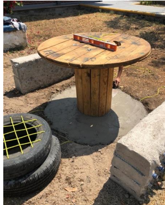
Ilustración 2. Empotramiento de carretes y unión de bancos con llantas a la mesa.
